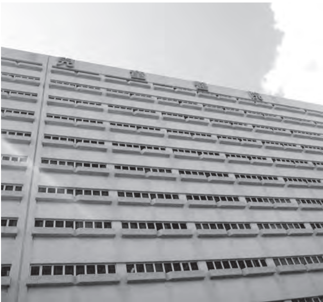
2,016床ある長庚病院を見上げる
